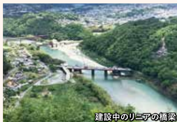
建設中のリニアの橋梁
